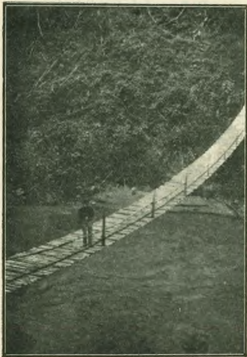
Mendez (Ecuador) — Un gran ponte sorpeso di 75 m. di lunghezza costruito dal venerando missionario salesiano Giacinto Pancheri sul Namangosa.
